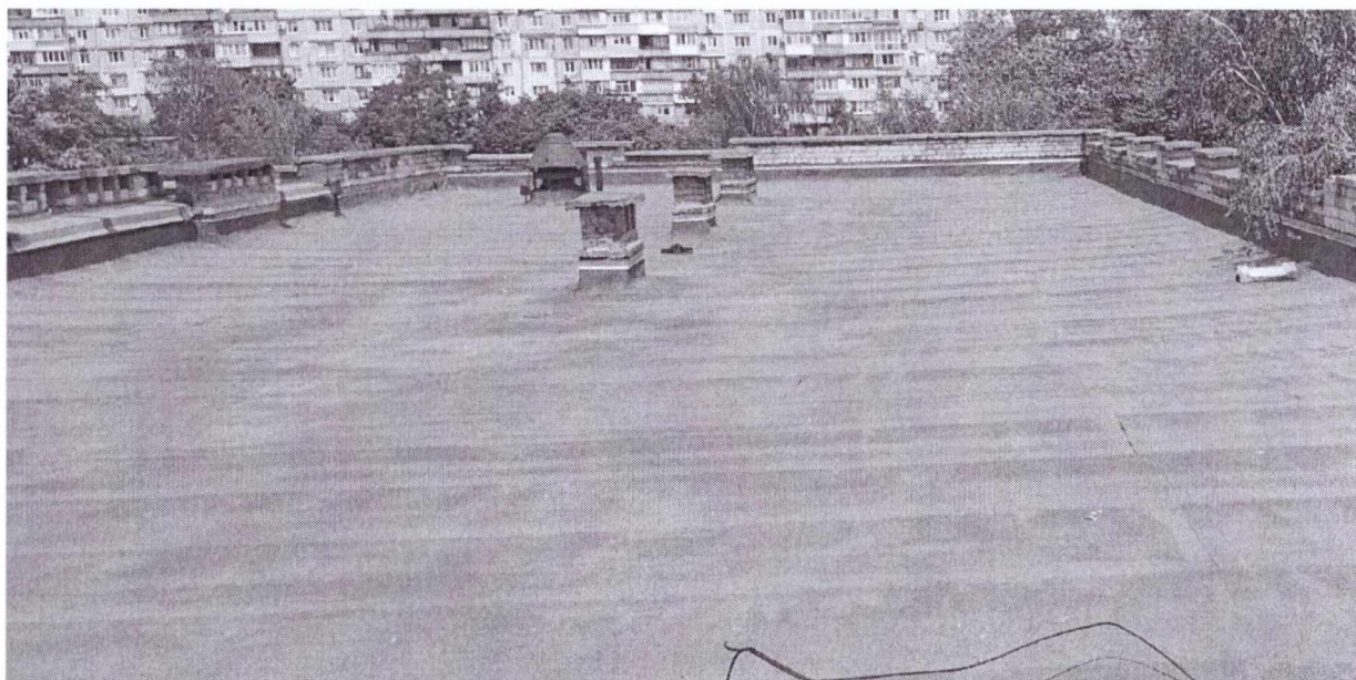
Фото 1. Загальний вигляд покрівлі
