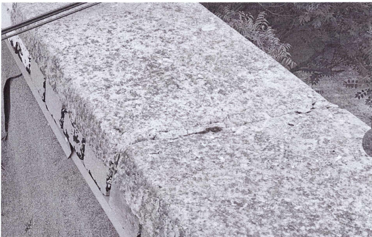
Фото 11: Відсутня гідроізоляція між парапетними плитами.
