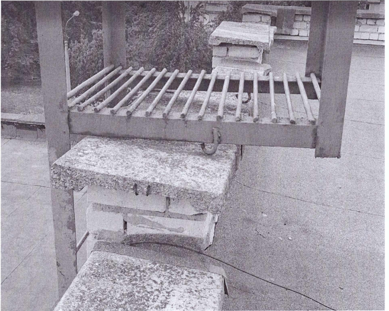
Фото 15. Вертикальні сходи виходу на покрівлю виконані з порушенням нормативної документації, відсутнє кріплення в верхньої частини сходів (дозволяється металевий елемент який упирається у парапет).
