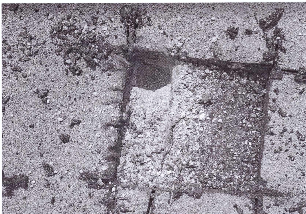
Фото 2: Вибірка покрівельного шару покрівлі
