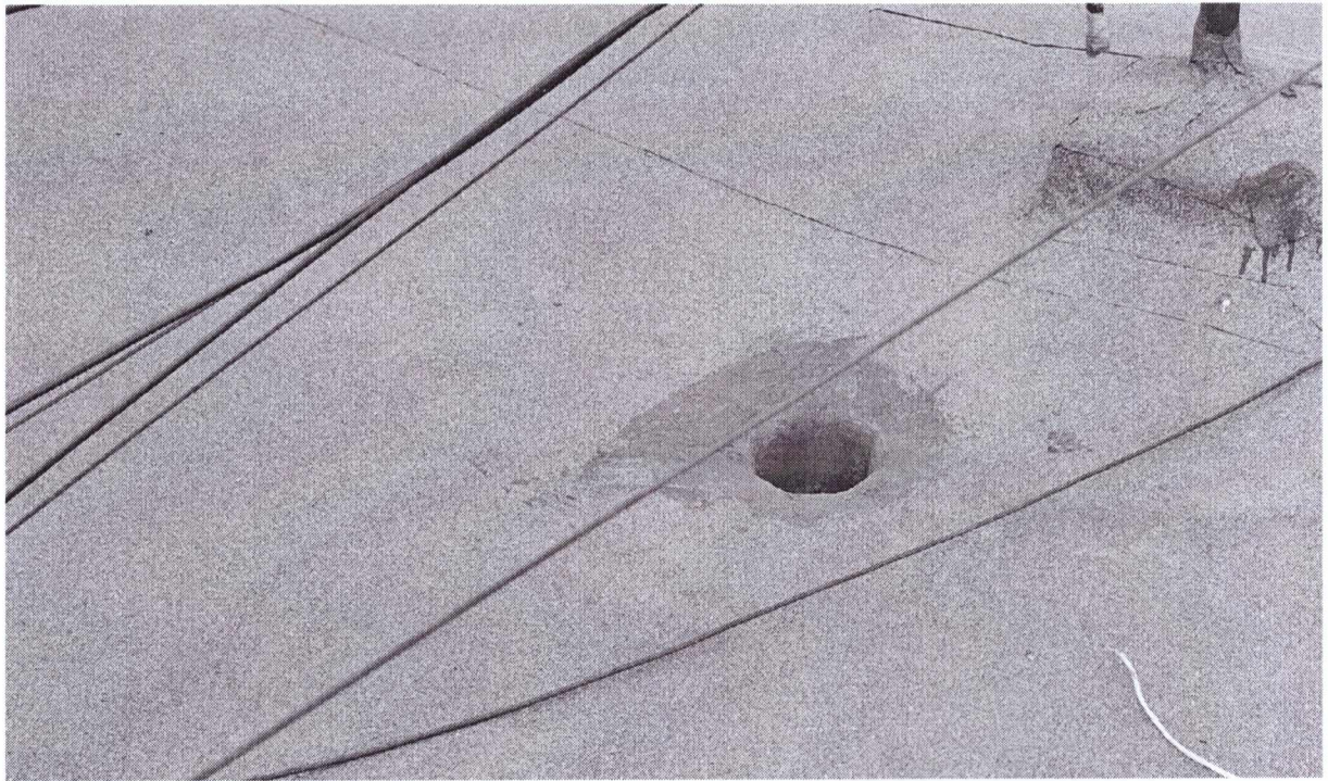
Фото 17. Відсутній листоуловлювач над водозливною воронкою.
