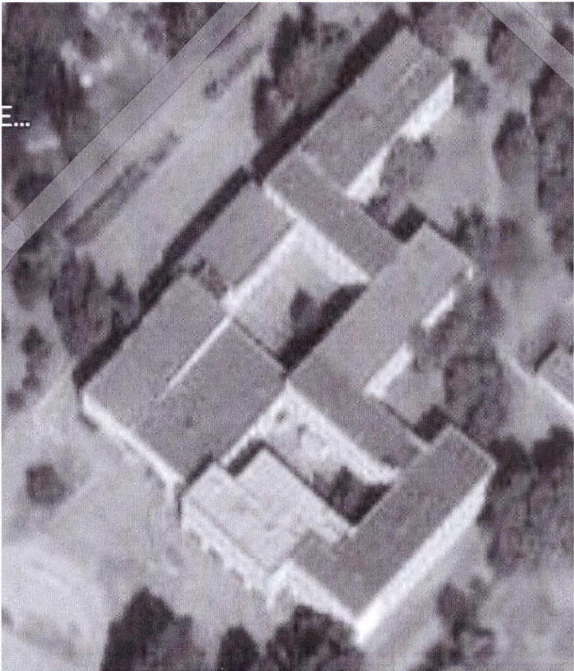
Фото 3. Випіювання з мапи м. Запоріжжя з місцем розташування обстежуємої покрівлі будівлі Запорізького багатопрофільного ліцею № 99
