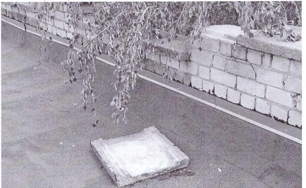
Фото 14: Відсутня парাপетна плита.
