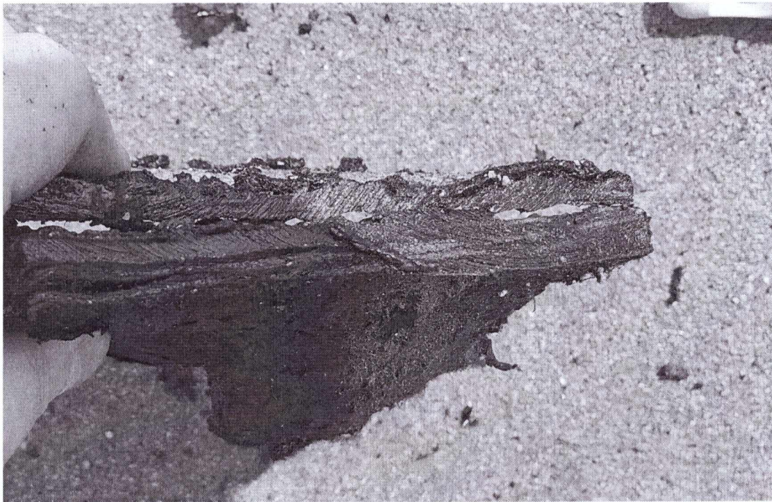
Фото 3. Покрівельний матеріал, 2 шари гідроізоляційного килиму.
