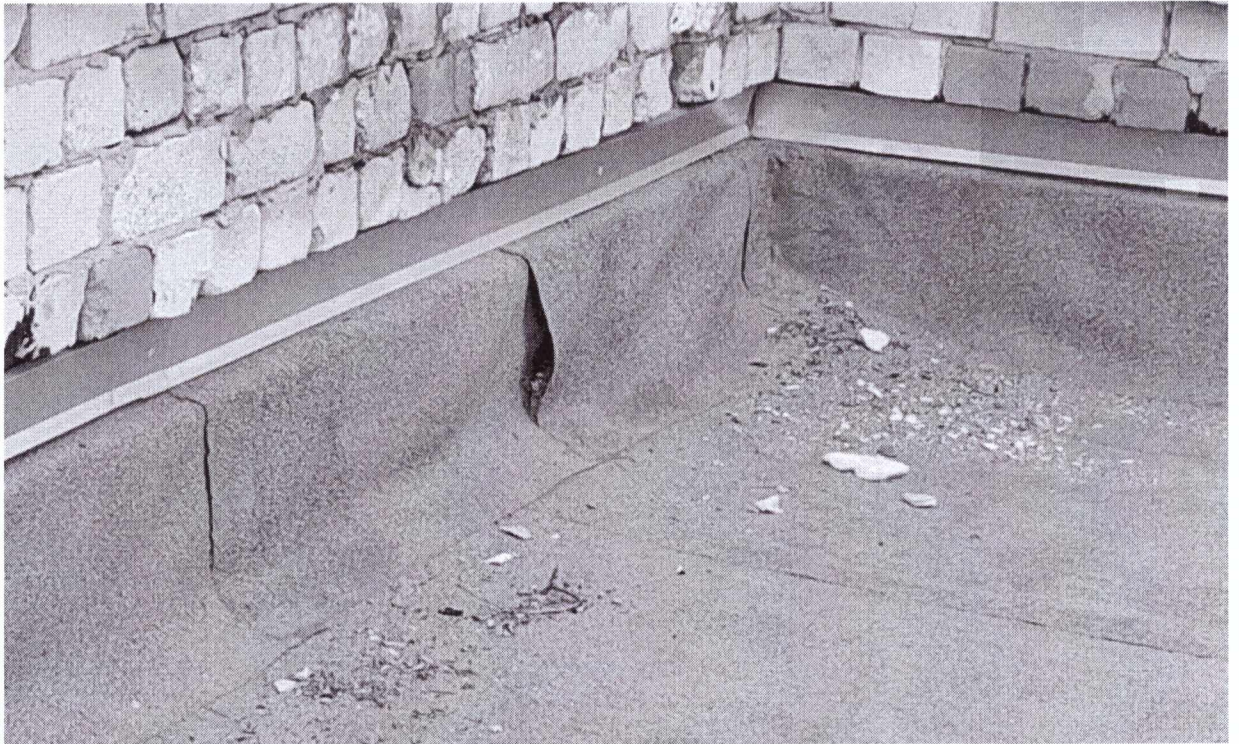
Фото 3: Відшарування рулонного матеріалу в ендовах покрівлі.
