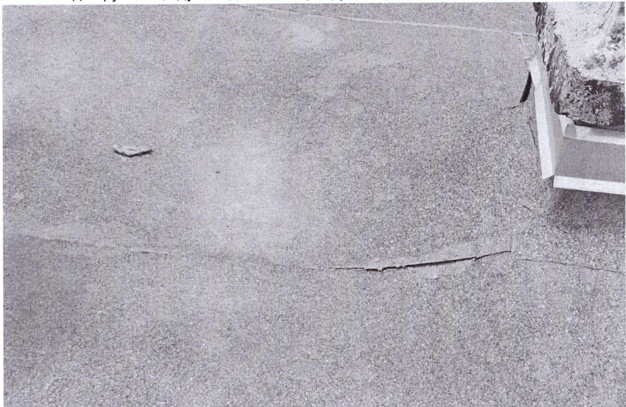
Фото 2: Відшарування, здуття одного з шарів рулонної покрівлі.
