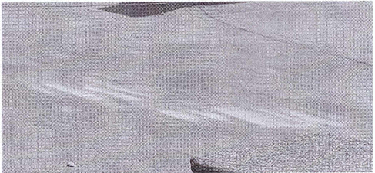
Фото 18. Скупчення будівельного сміття на покрівлі.
