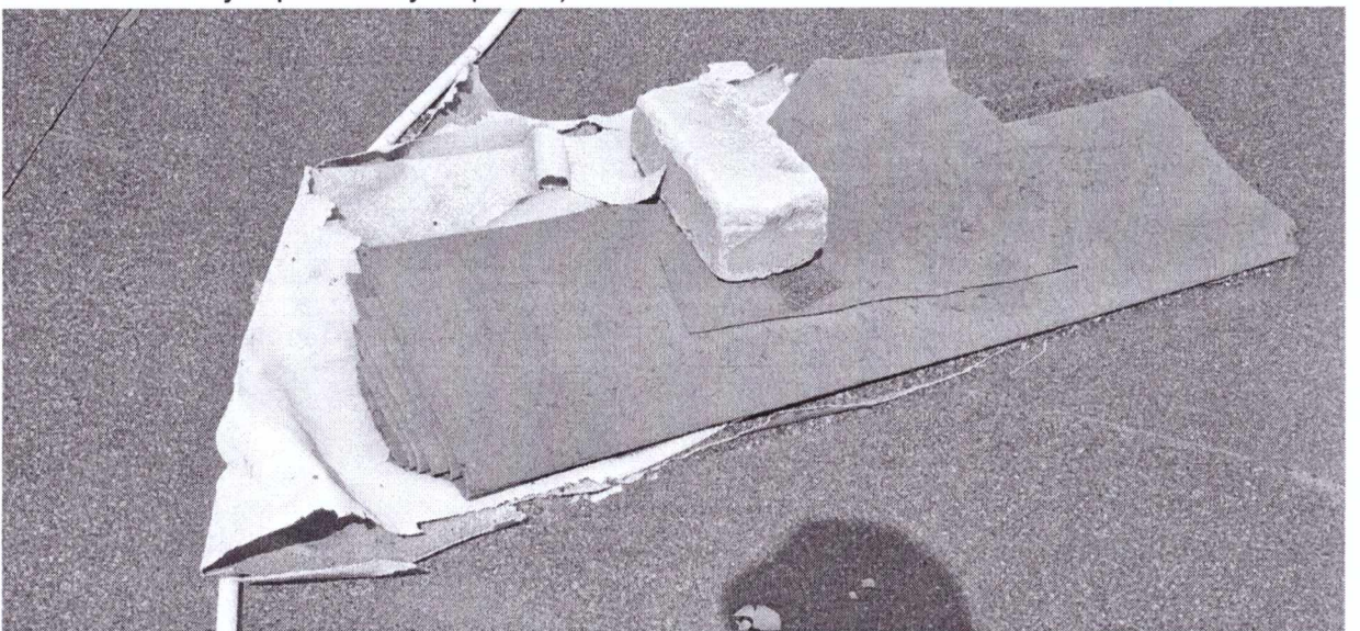
Фото 16. Скупчення будівельного сміття на покрівлі.
