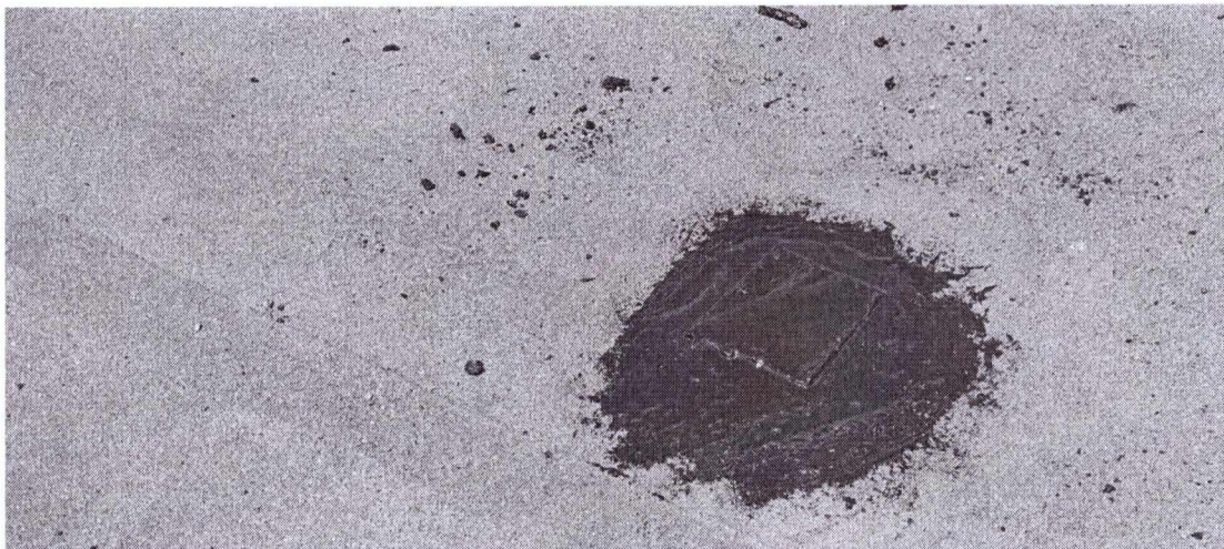
Фото 4: Відновлення цілісності гідроізоляційного шару покрівлі.
